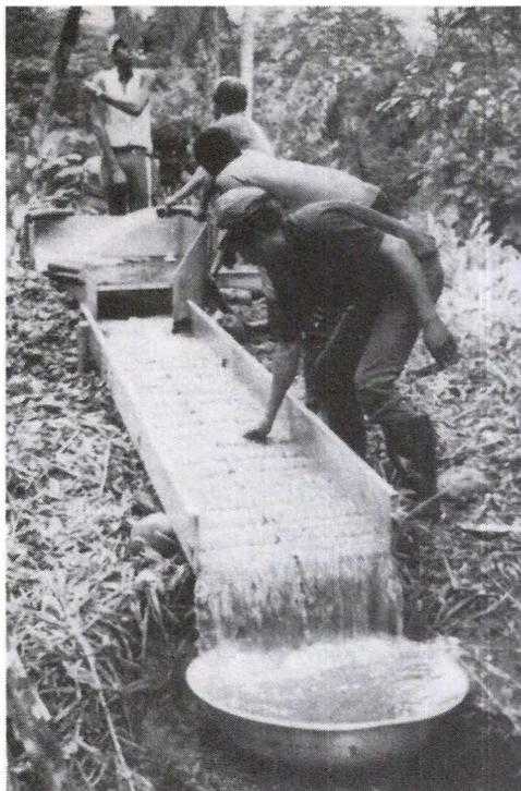
Figura 5: Concentración de minerales pesados con "Sluice Box"
